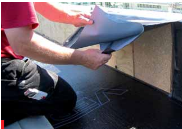
Do wykonania obróbek elementów dachów skonstruowanych z materiałów łatwopalnych, jak sklejką lub płytą OSB Termo-Dek stosuje również papy podkładowe samoprzylepne
