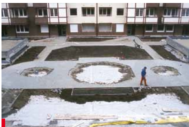
Fot. 7. Wykonywanie nawierzchni na stropodachu garaży
