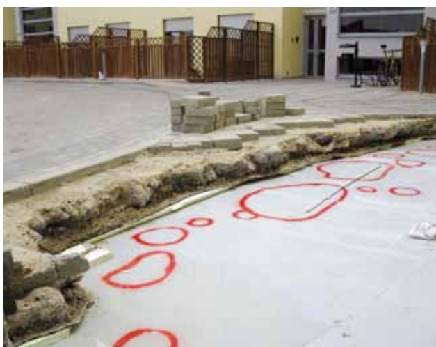
Fot. 2. ...są zbyt delikatne w warunkach budowy dachów użytkowych (tutaj PCV)
