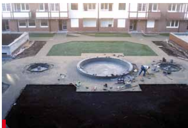
Fot. 8. Żelbetowa konstrukcja piaskownicy posadowiona jest powyżej warstwy drenażowej
